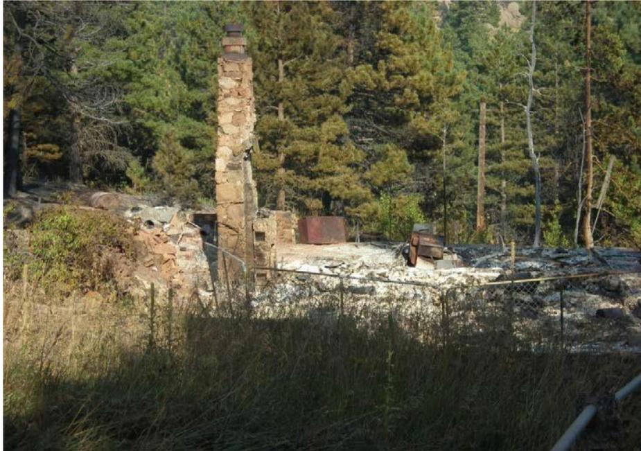
Figura 10. Exemplo de uma casa completamente destruída, cercada por vegetação não ardida (fotografia retirada de Graham et al.(2012))
